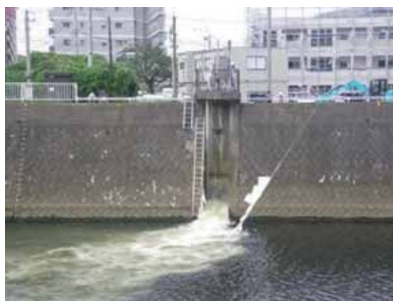
【ポンプ場*故障による未処理下水の河川流出】
