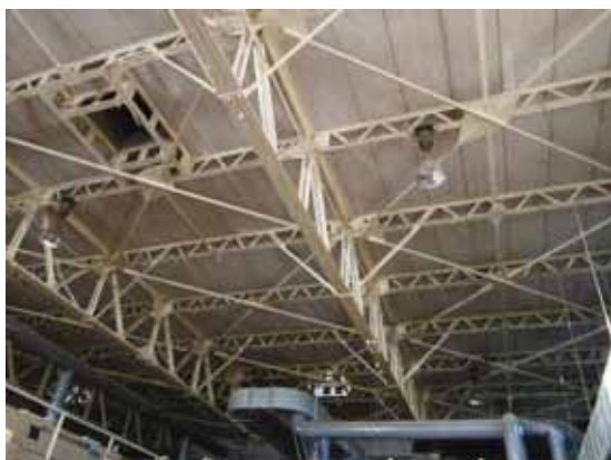
【施設の耐震化*】 藤が谷ポンプ場 プレース*設置
