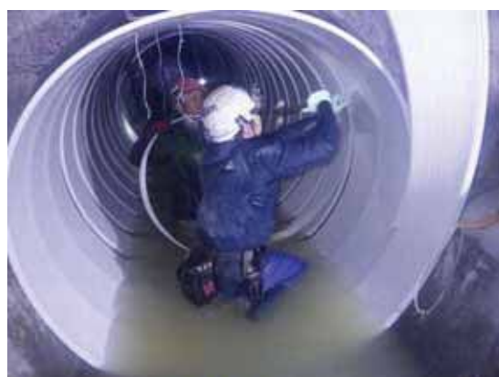
【管路*の耐震化*】 管更生*
