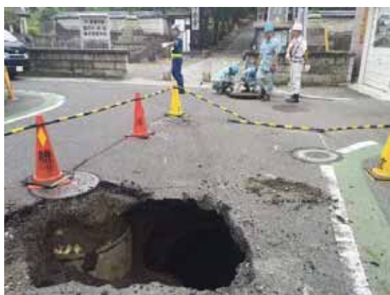
【管路*老朽化に起因する道路陥没】
