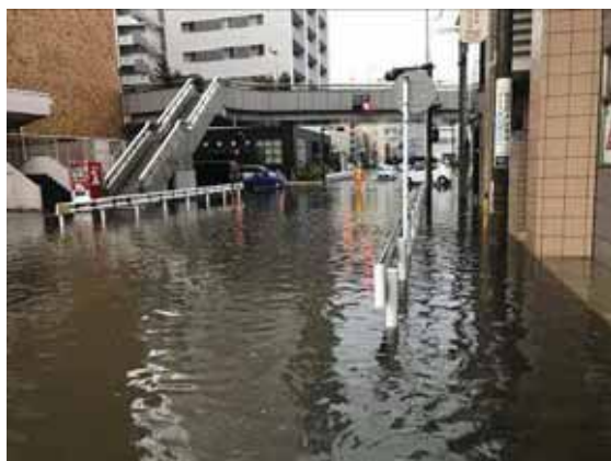
【内水浸水*状況】 奥田公園前交差点
